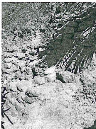
Figura 19. Sección de muro del Edificio 137 en su esquina Sureste
